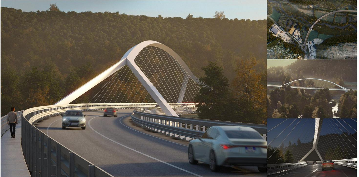
El puente principal tiene un desarrollo total de 280 m, medido entre los ejes de los estribos, con un trazado rectilíneo. Está formado por cinco vanos de longitud variable: 34 + 36 + 140 + 36 + 34 m. La sección transversal tiene una anchura de 25 m y alberga dos carriles por cada sentido de circulación. El puente arco principal que cruza el río Guadalfeo tiene una luz entre apoyos de 140,0 m, comparable al puente objeto del presente concurso.
